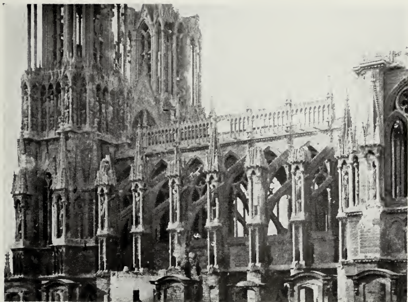
CONTREFORTS LATÉRAUX (CÔTÉ SUD)
